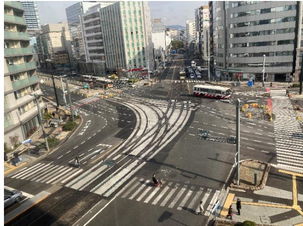
稲荷町交差点の改修作業
