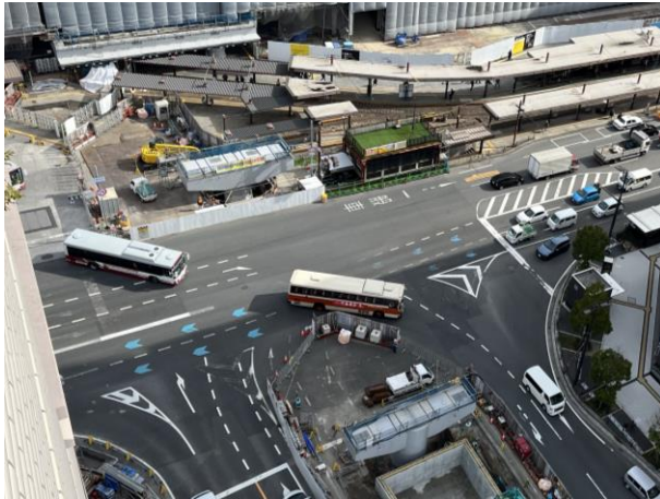
高架橋の下部工事
